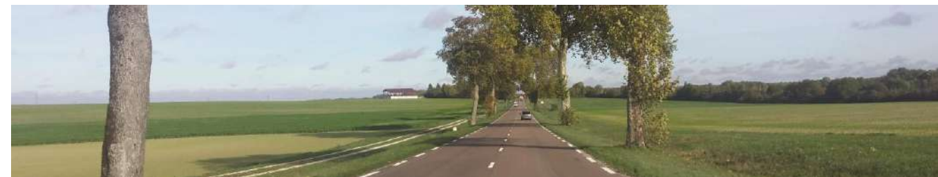
Figure 40 : Route départementale n°677 (Source : Intervent)
