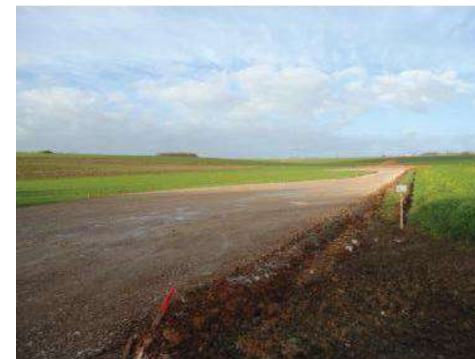
Figure 58 : Chemin d'accès à l'éolienne, parc éolien de Bourthes (Source : Intervent)
