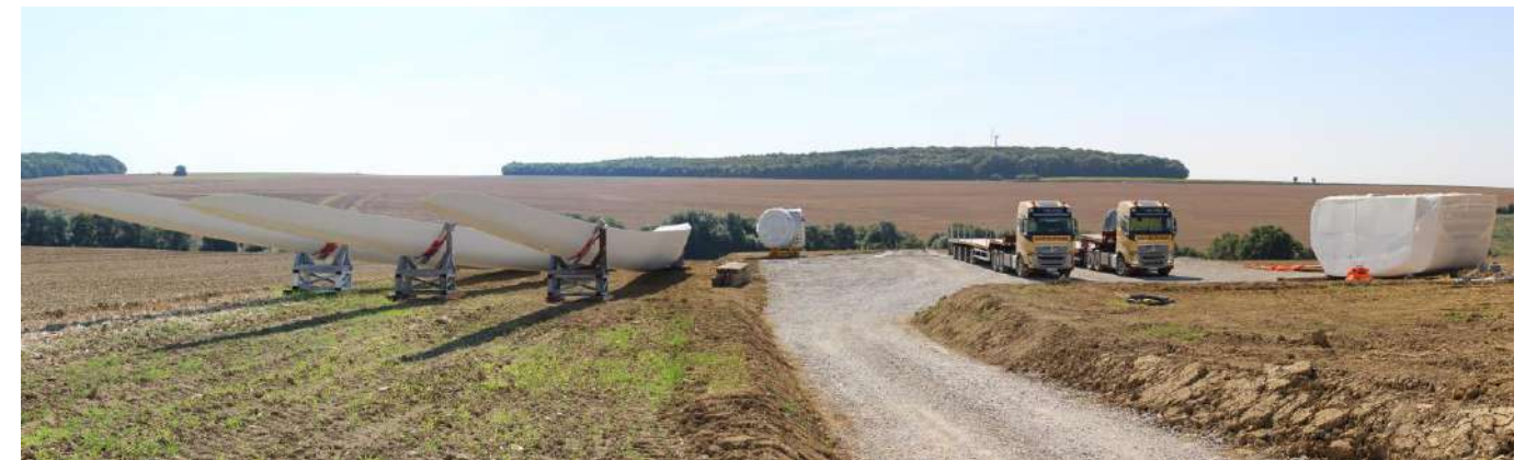
Eléments d'éoliennes avant montage (Source : Ora environnement)
