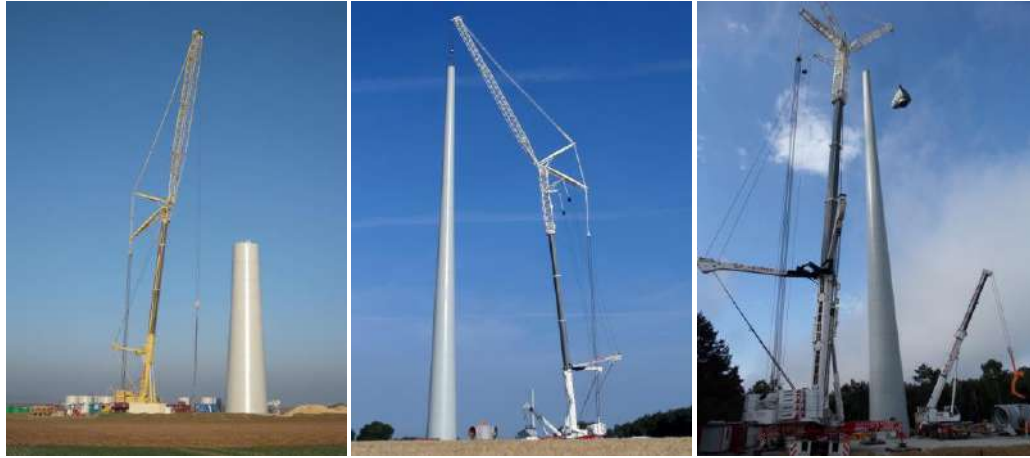
Assemblage du mât (Source : ENERCON)
