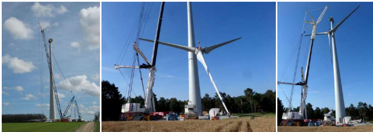
Etapes du montage du rotor d'éolienne (Source : ENERCON)
